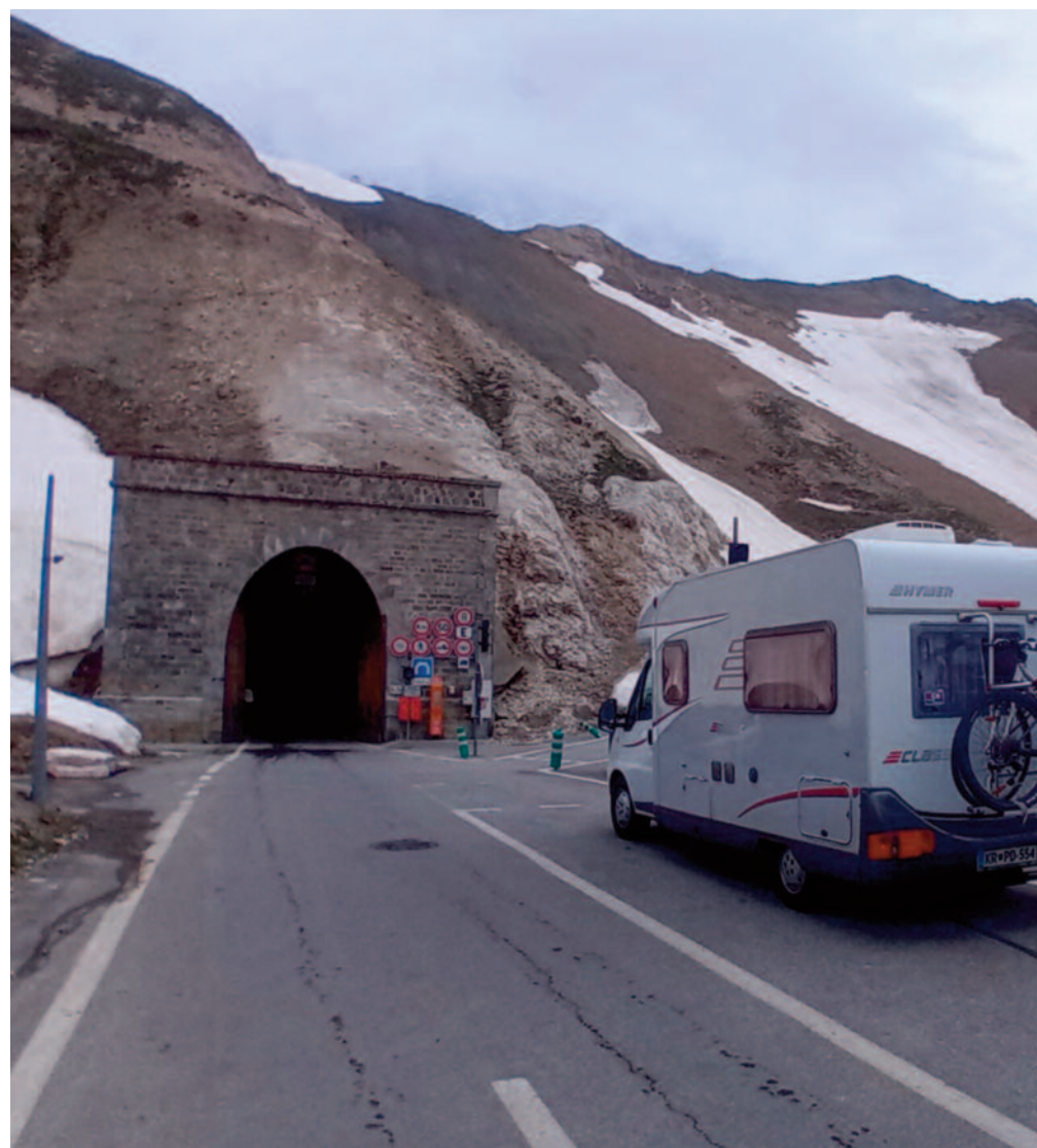
Tunel tik pod vrhom.
