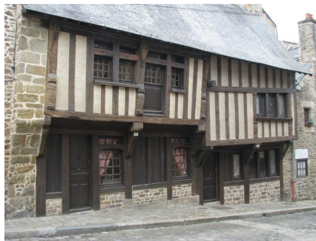
predalčna gradnja, ki je že malo iz »waservage«
