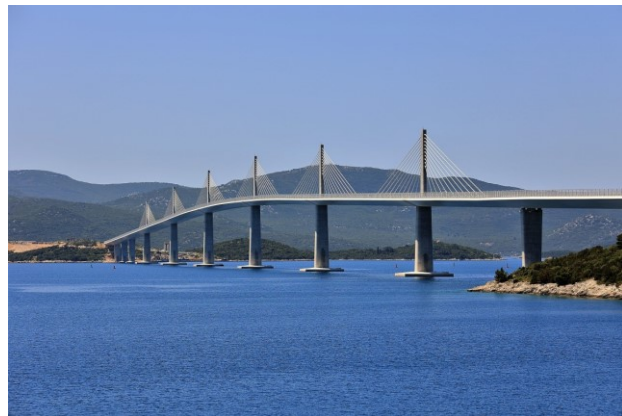
Most na Pelješac še ni bil odprt za promet
