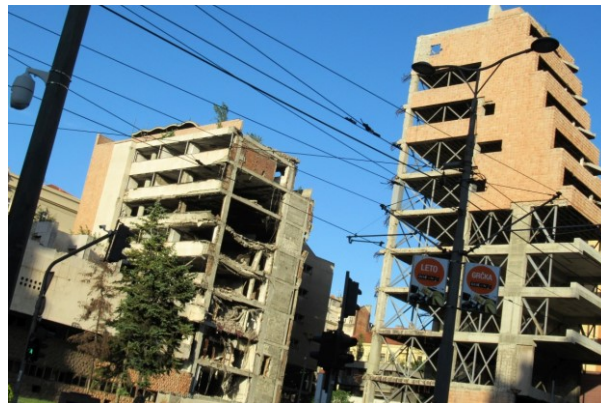
Nekatere zgradbe v BG še niso obnovljene
