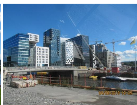
Moderni del mesta
