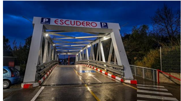
Do parkirišča Escudero je treba čez most
