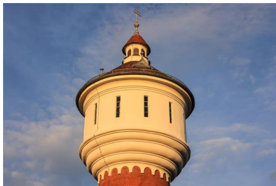
Vodovodni stolp v Schillingsfürstu
